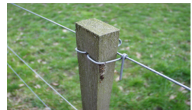
Am Hartholz sind keine Isolatoren notwendig
